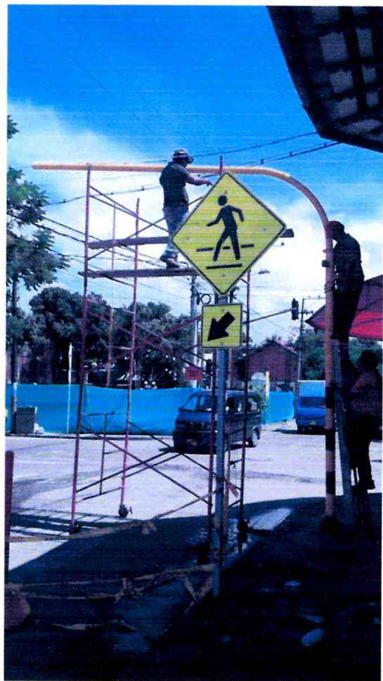
INSTALACION DE POSTE T2
