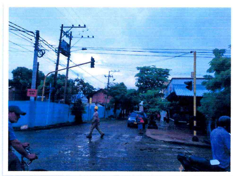
POSTES Y SEMAFOROS EXISTENTES
