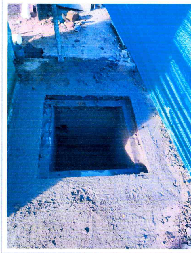
CONSTRUCCION CAJA DE PASO
