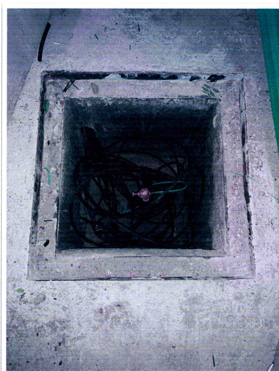
INSTALACION DE LA VARILLA COOPER WELL
