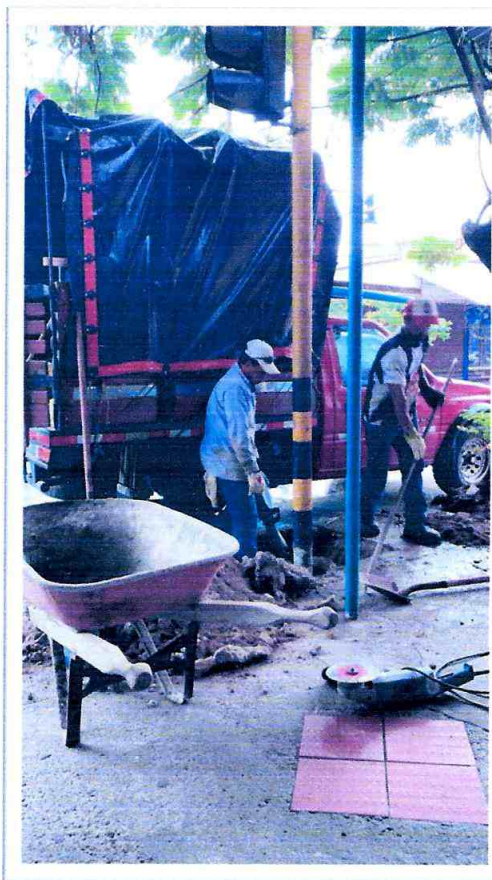
RETIRO DE POSTE T1
