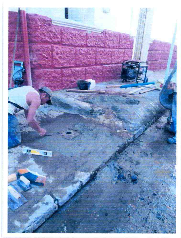
CONSTRUCCION DE BASE PARA POSTE
