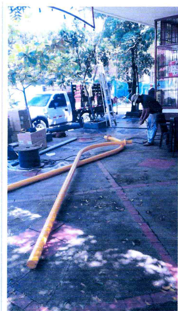
INSTALACION DE POSTE T2
