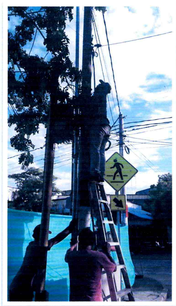
INSTALACION DE LA BAJANTE DE 2"
