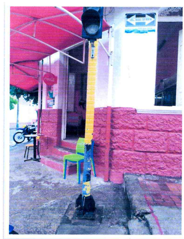
RETIRO DE POSTE T2
