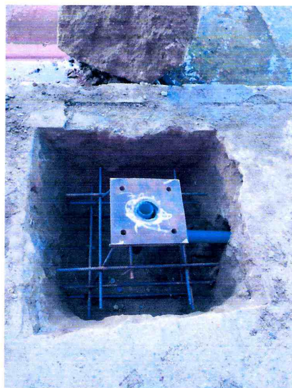
CONSTRUCCION DE BASE PARA POSTE
