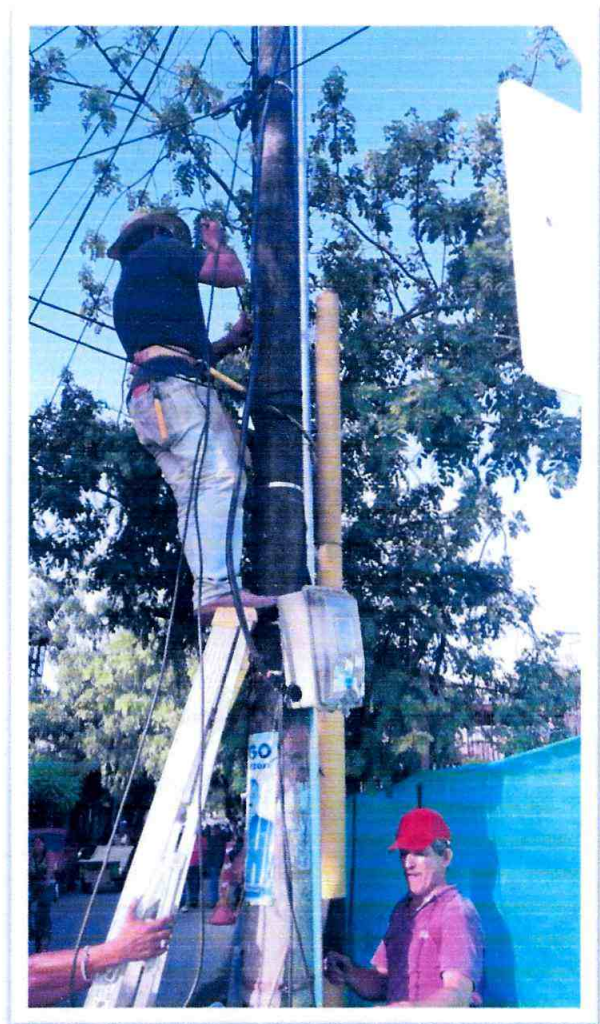
INSTALACION DE LA ACOMETIDA ELECTRICA
