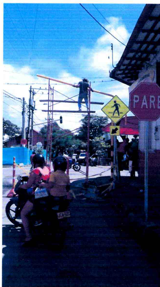
INSTALACION DE POSTE T2
