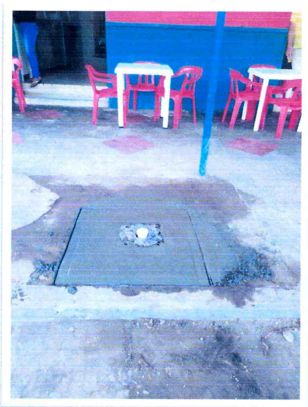
CONSTRUCCION DE BASE PARA POSTE
