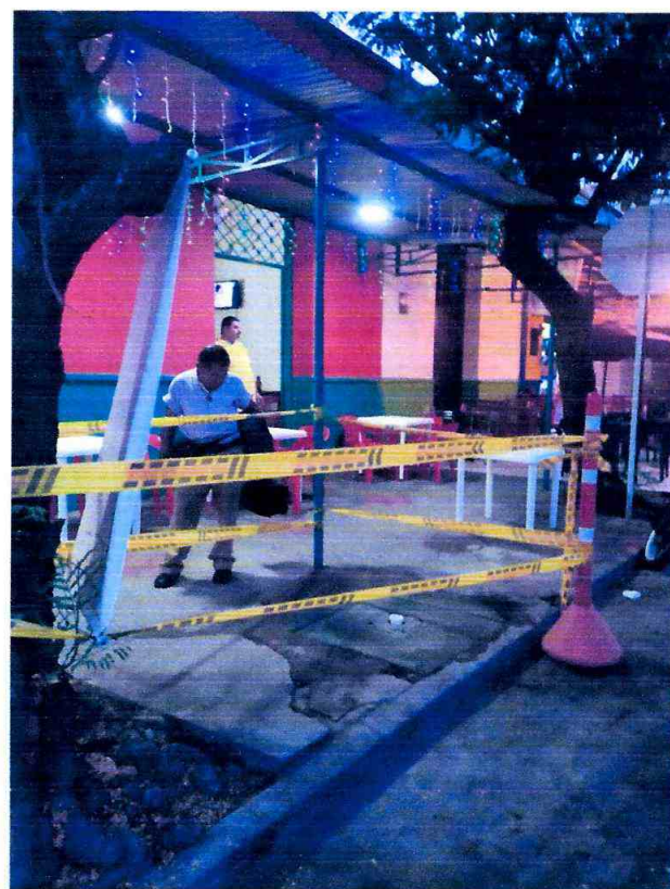
CONSTRUCCION DE BASE PARA POSTE
