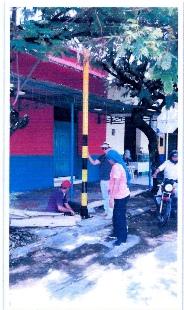
INSTALACION DE POSTE T2
