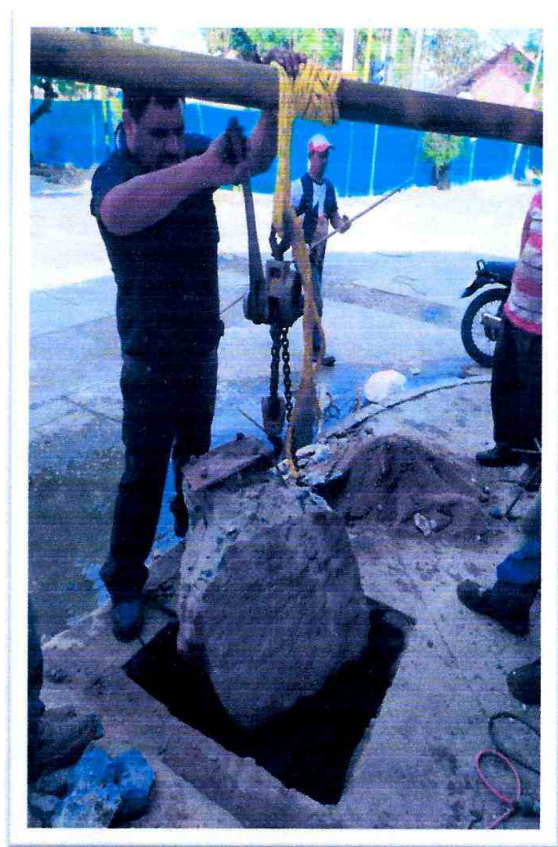
CONSTRUCCION DE BASE PARA POSTE
